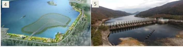
4 마산항 서항지구 친수공간 조성공사
