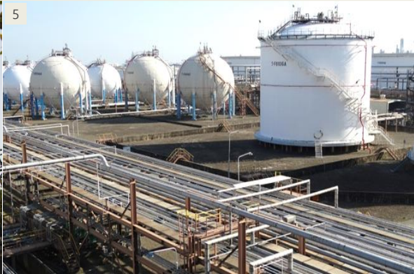
4 대한유화 EO/EG Project
