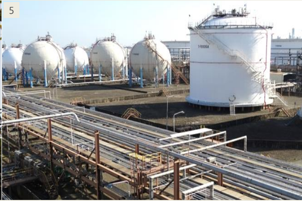
4 대한유화 EO/EG Project
