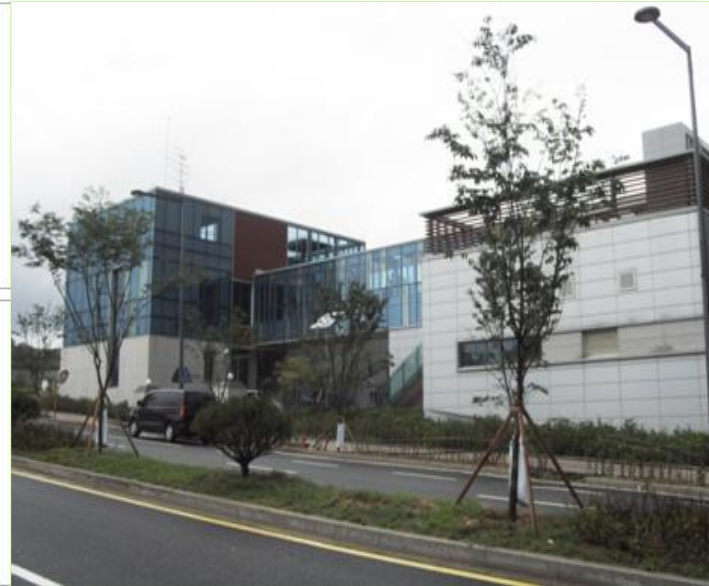
㉕ 첫마을 지구 생활폐기물 자동집하시설 건설공사
