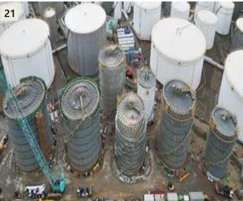
21 정일 석산탱크 건설공사
